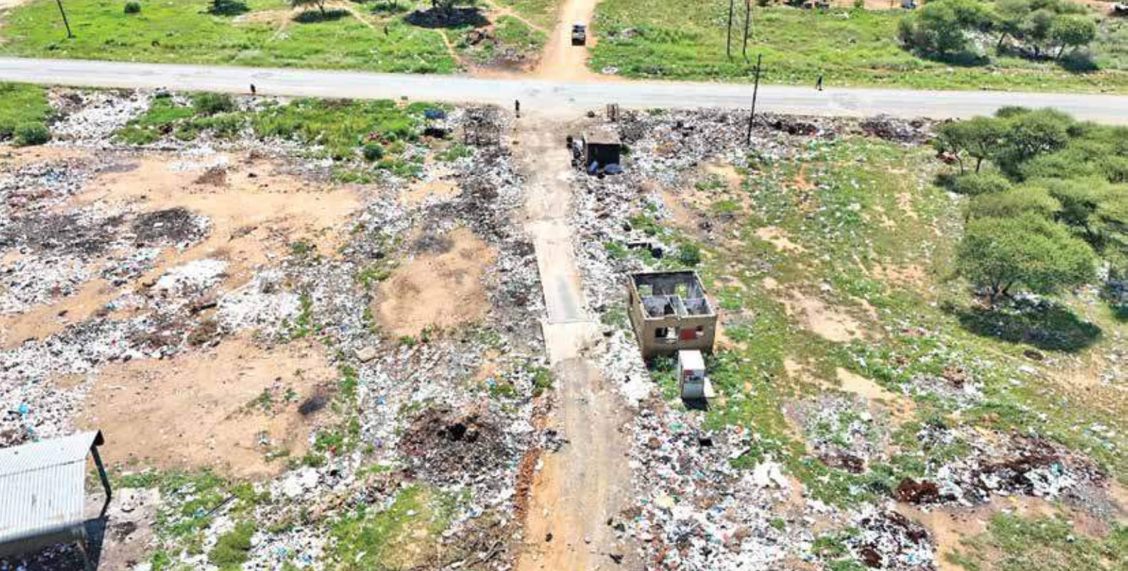
'n Stukkende weegbrug, geplunderde infrastruktuur en gebrek aan toegangsbeheer by Hartswater se munisipale vullisterrein in die Noord-Kaap.
